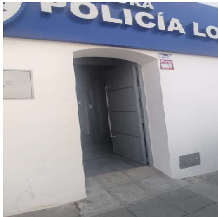
Dependencias de la Policía Local. Solución que alterna aciertos (contraste cromático) con desaciertos (no se dispone de felpudo enrasado)
