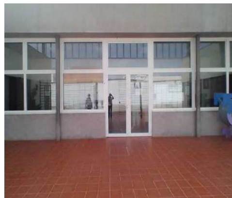
Es necesario señalar con marcas de color las puertas de vidrio. Es preferible combinar distintos colores para facilitar su percepción. En la imagen, el Centro de Servicios Sociales de Aznalcollar.
