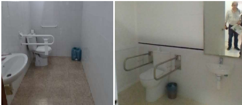
Sanitario correspondiente al Hogar del Pensionista (izquierda) y Sala de Conferencias, en Aznalcollar.. La señalización, la iluminación y la utilización de materiales contrastados son factores esenciales a considerar. Se aprecian luces y sombras en estos casos.
